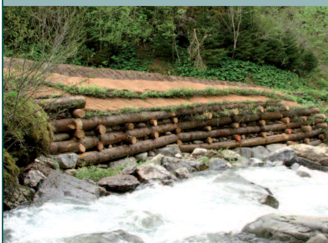
Soutènement de berge d'un torrent (contre l'érosion régressive) par caisson végétalisé en FD de Saint Hugon (38)
