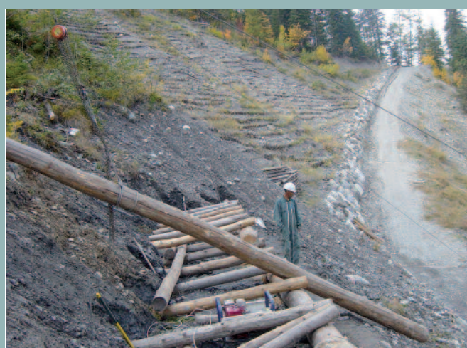
Ouvrage double paroi ; mise en place des éléments bois par câble
