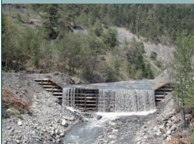
Barrage double paroi réalisé en 2009 sur le torrent du Riou Bourdoux (04) : la plus grosse réalisation depuis le barrage « Poncet » en 1961
