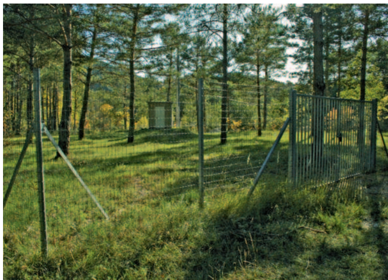
Périmètre de protection de captage immédiat (PPI) en forêt communale de Comps-sur-Artuby (Var)
