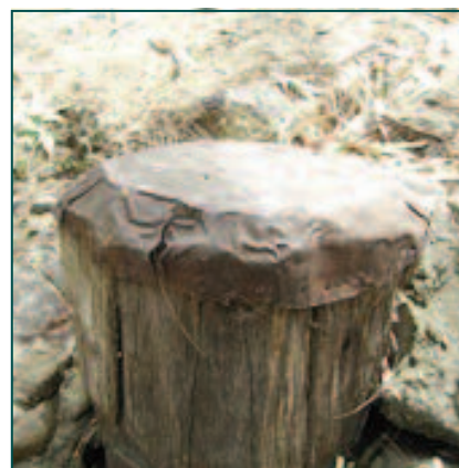
Protection des têtes de pieux d'un ouvrage d'irrigation australien (Bonshaw weir) construit en 1953
