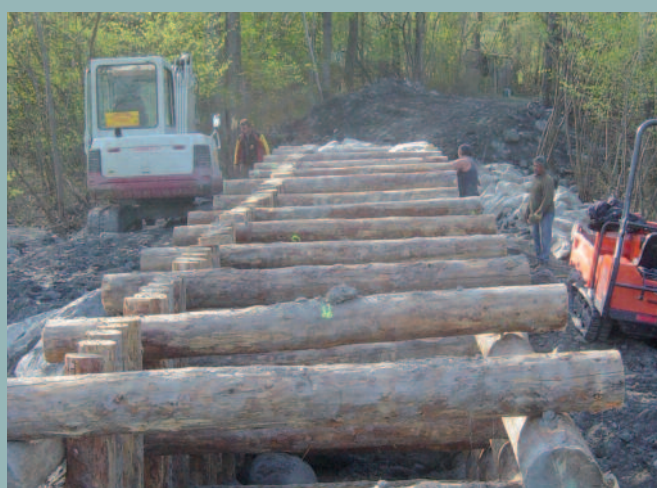
Construction d'un épi de protection double paroi ; torrent de Beauvoir, 2010
